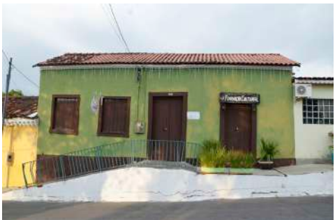
19. Rua Marechal Rondon, 628
